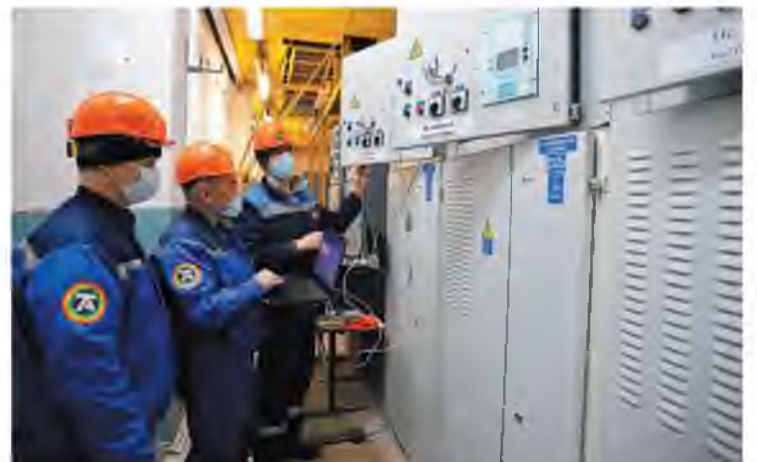
Наладка микросхем релейной защиты на подстанции для третьего агрегата карбамида
